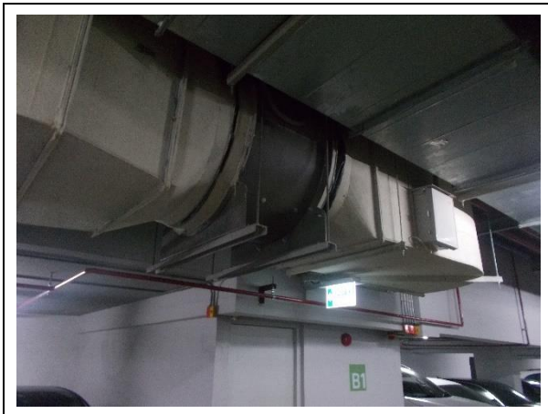
รูปที่ 2-5 ระบบระบายอากาศบริเวณลานจอดรถใต้ดิน
