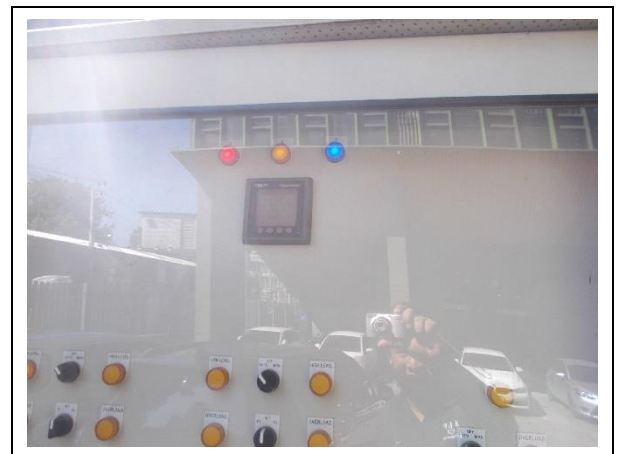
รูปที่ 2-10 มิเตอร์ไฟฟ้าสำหรับระบบบำบัดน้ำเสีย
