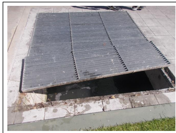
รูปที่ 2-23 ตะแกรงดักขยะที่บ่อพักน้ำสุดท้าย
