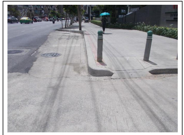
รูปที่ 2-11 ตัดคัดหินทางเท้าเพื่อเปิดทางเข้า - ออก รถยนต์
